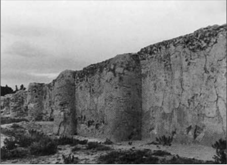
10.5. Le grand bassin de Raḡḡāda, près de Ḳayrawān ; les énormes contreforts brisaient les vagues provoquées par le vent.
