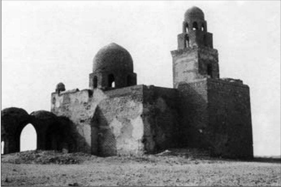
7.8. Mosquée al- Djuyūshī . Vue générale du côté est.
